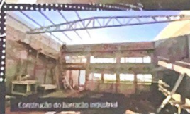
Construção do barracão industrial
